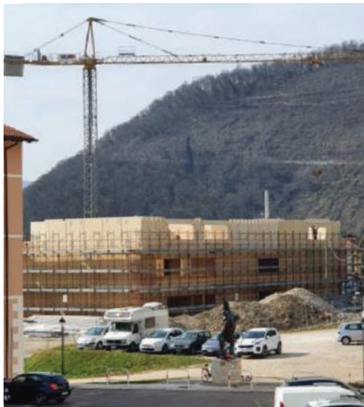
Il cantiere per la sistemazione della scuola Foscolo. LITTURI
