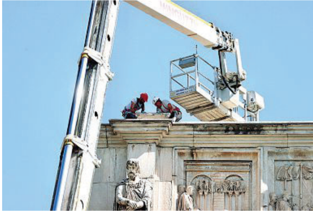
Due operai impegnati ieri nella messa in sicurezza dell'Arco di Costantino (foto Claudio Guaitoli)
