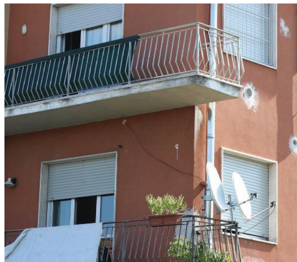
Il balcone dell'abitazione di via Provinciale dove il bambino è stato raggiunto dal colpo d'arma da fuoco
